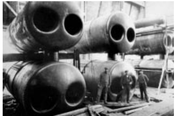
Dampfkessel im Kraftwerk vor der Montage, 1909.
