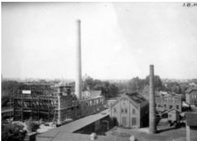
Bauphase des Kohlekraftwerkes der PESAG in Paderborn, 1909.
